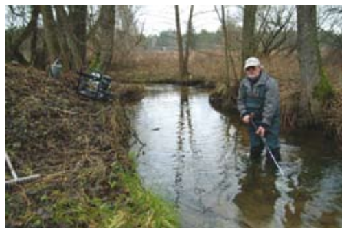
2 pav. Upės vagos gilinimas naudojant aukšto slėgio vandens aparatą (Foto H. Sakalausko)
